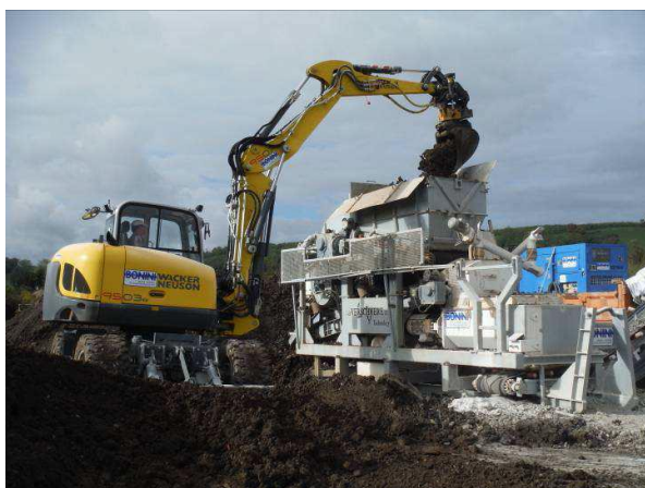
Chargement en matériau brut de la machine à chauler
