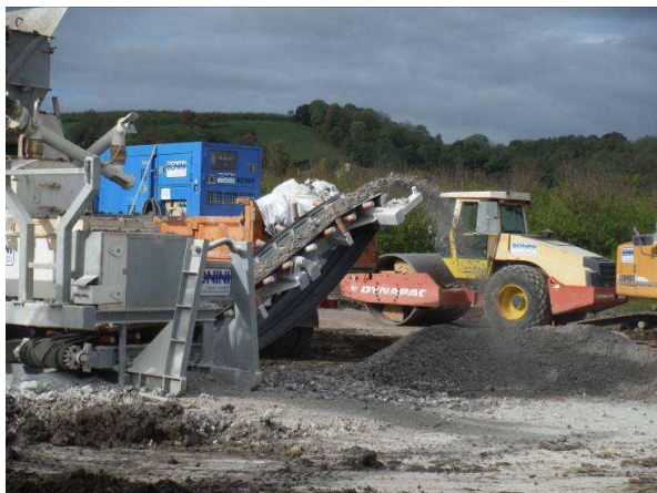
Matériau chaulé après criblage, pesée, ajout de chaux (1%), et malaxage
