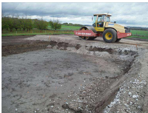
Mise en œuvre du matériau traité avec le compacteur vibrant monocylindre
